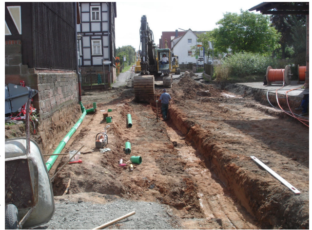
Ein Teil der Großbaustelle zwischen Sommer- und Winterseite
