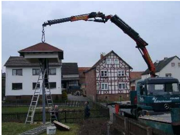
Ein Kranwagen hebt das fertig gezimmerte Schwalbenhaus auf den Stahlmast
